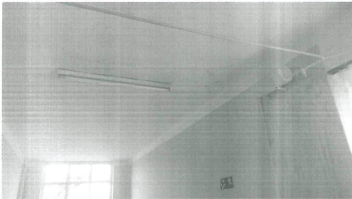
Fot. 16 Zawilgocenie ścian i sufitów wskutek nieszczelnego dachu
