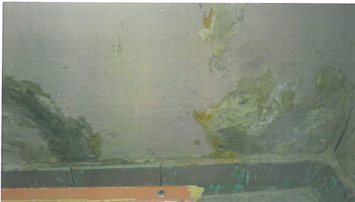
Fot. 12 Skorodowane elementy stalowe w piwnicach
