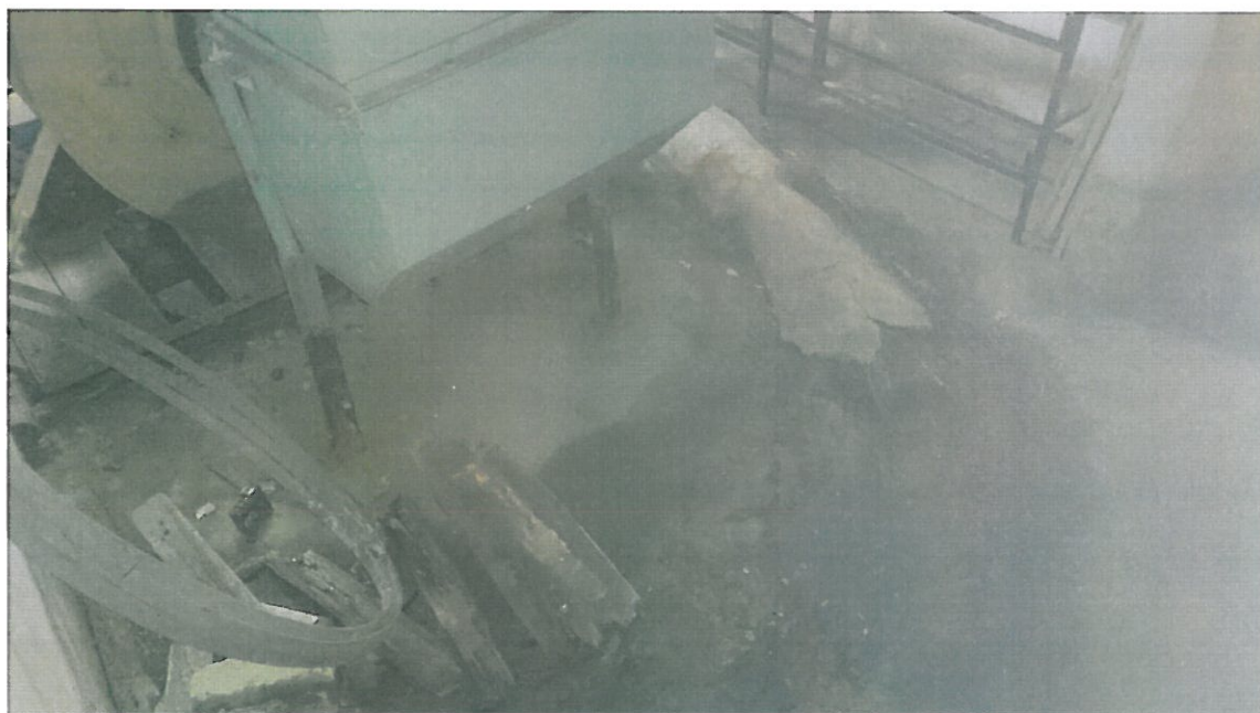
Fot. 8 Gromadzącą się wodą w otworze w posadzce
