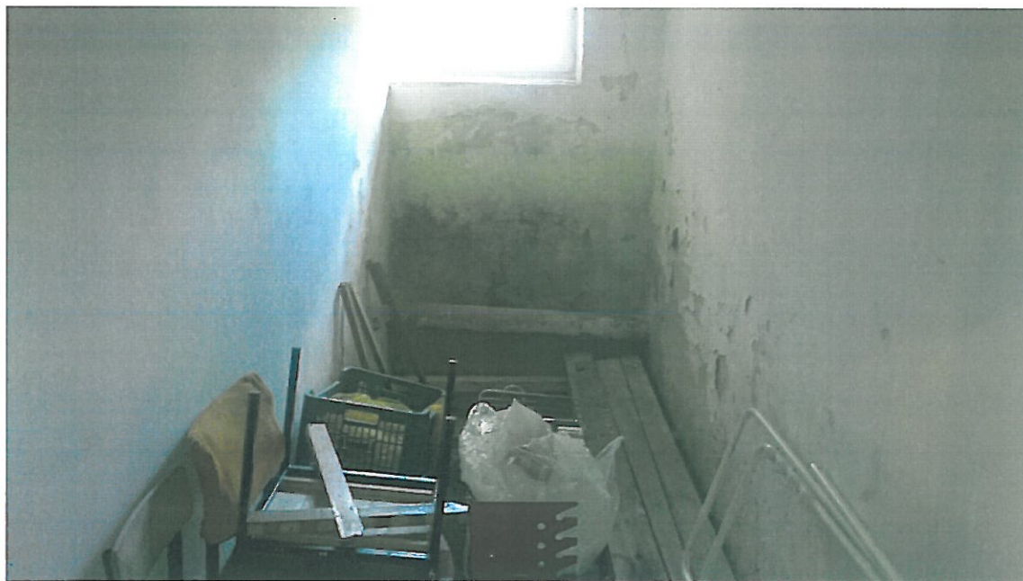
Fot. 10 Całkowicie mokra, zagnięta i zagrzybiona ściana piwnic
