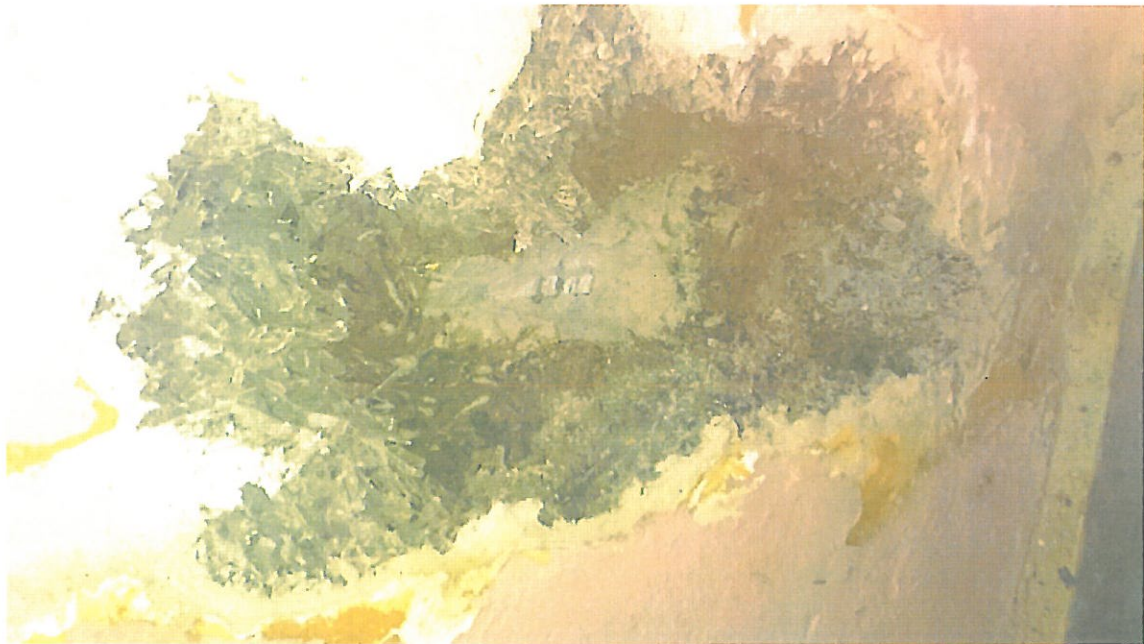
Fot. 4 Całkowicie mokra i zagniła izolacja ścian piwnic z płyt wiórowo - cementowych
