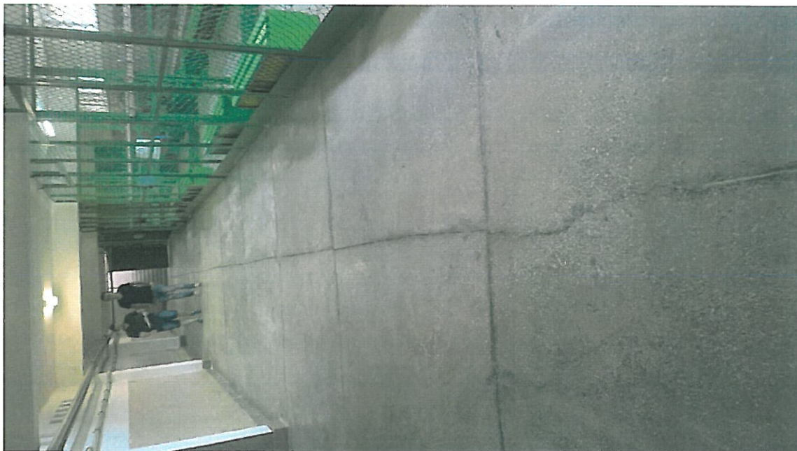
Fot. 2 Nieszczelna i popękana posadzka w piwnicy ze śladami penetrującej wody
