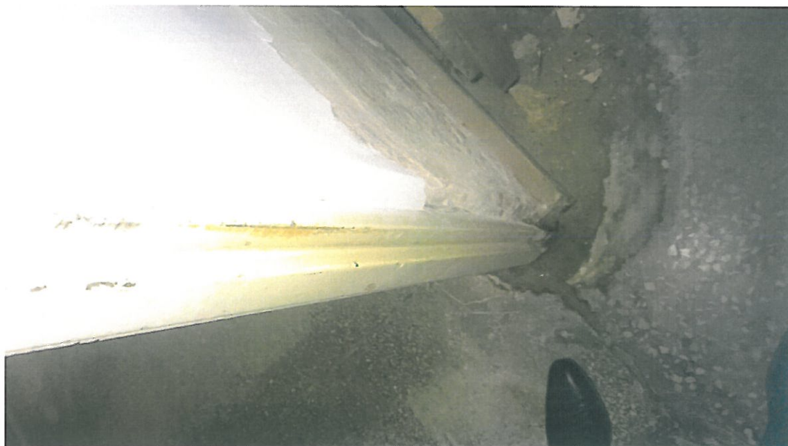
Fot. 6 Całkowicie mokra , zagniała i zagrzybiona ściana działowa piwnic wraz z nieszczelną posadzką
