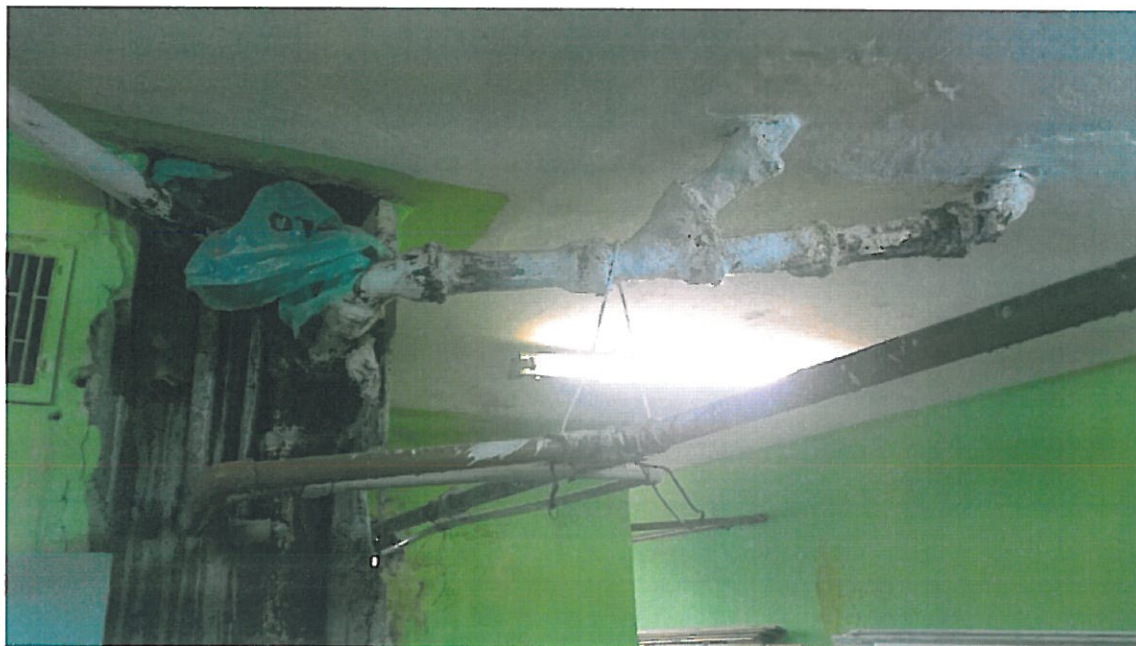
Fot. 12 Skorodowane elementy stalowe w piwnicach
