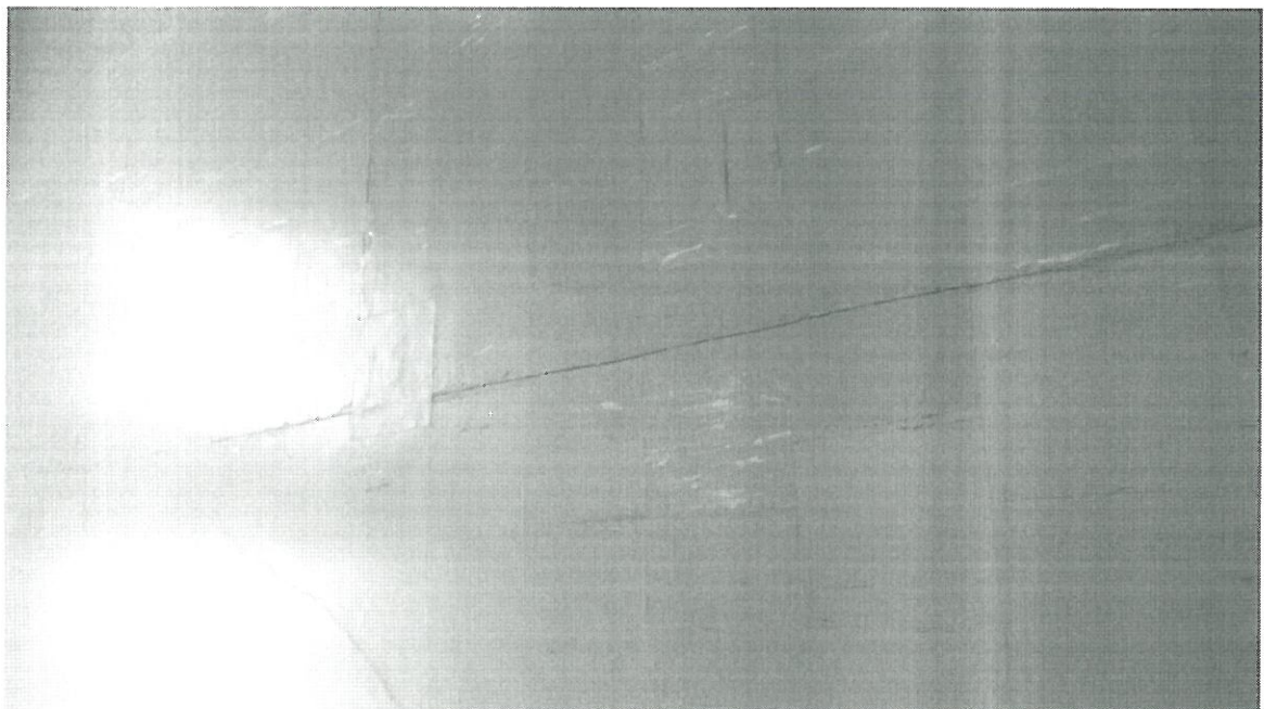
Fot. 25 Zarysowanie posadzki na wskutek klawiszowania płyt stropowych
