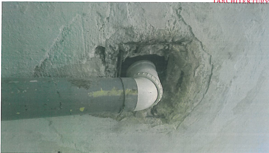
Fot. 13 Zalewanie budynku poprzez brak prawidłowego odprowadzenia wody z rynien
