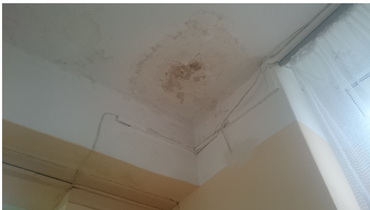
Fot. 19 Zawilgocenie ścian i sufitów wskutek nieszczelnego dachu
