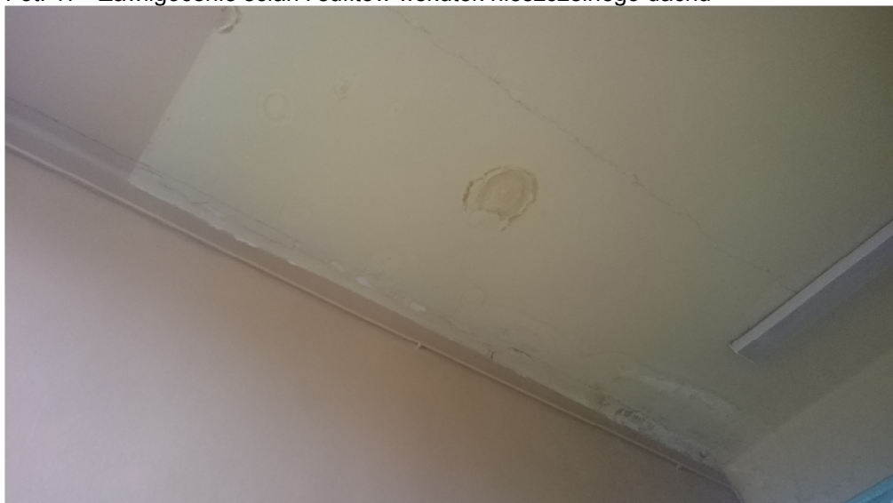
Fot. 17 Zawilgocenie ścian i sufitów wskutek nieszczelnego dachu
