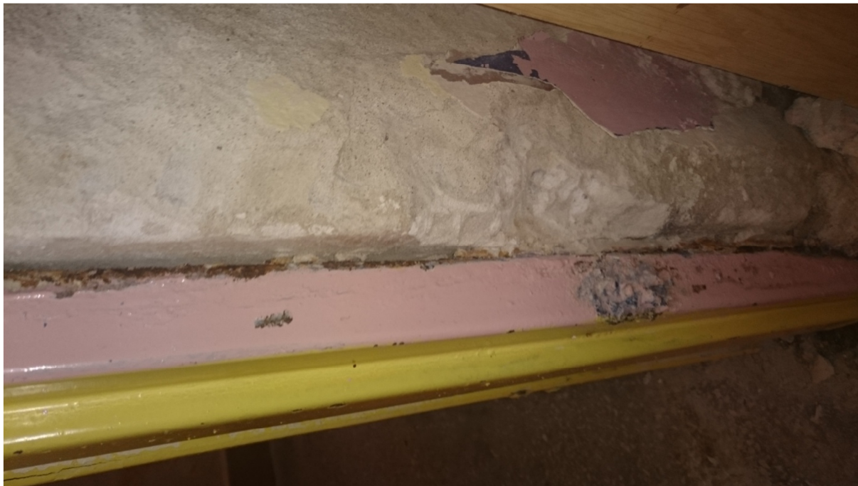
Fot. 10 Całkowicie mokra , zagniała i zagrzybiona ściana piwnic
