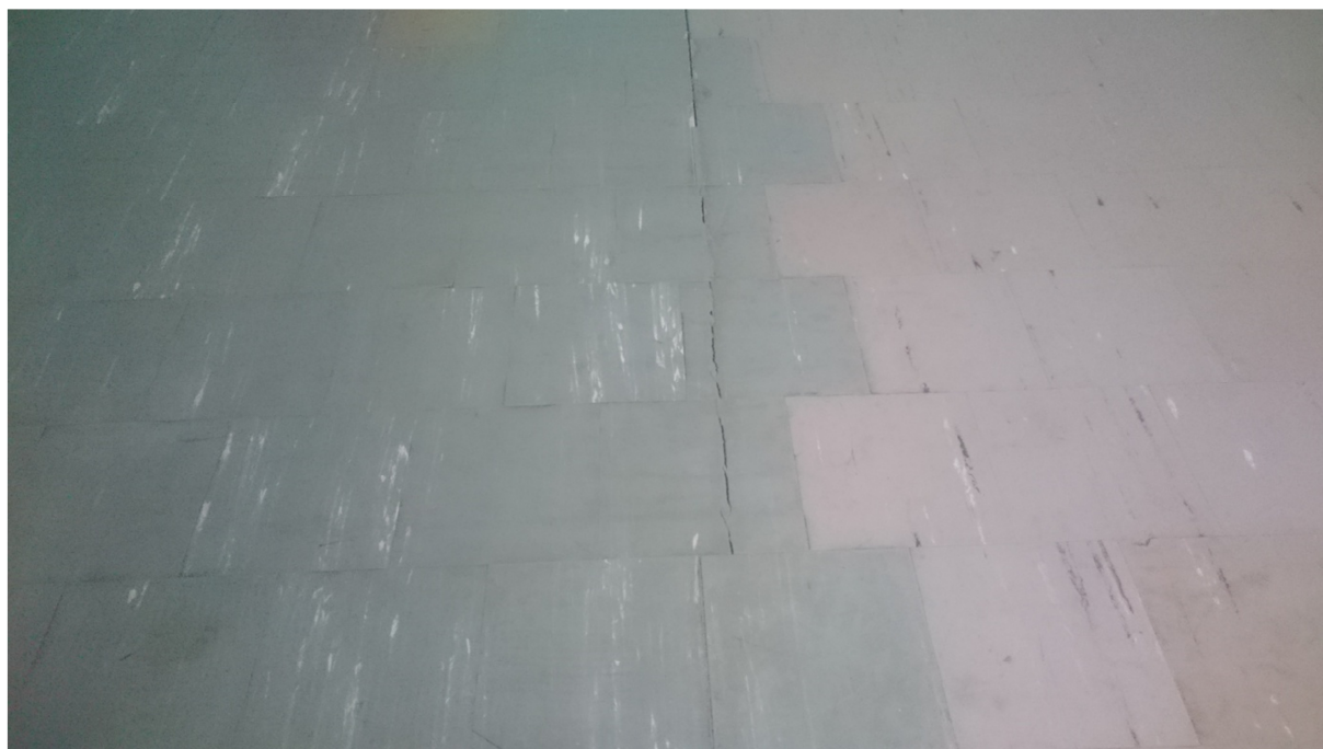
Fot. 22 Zarysowanie posadzki na wskutek klawiszowania płyt stropowych
