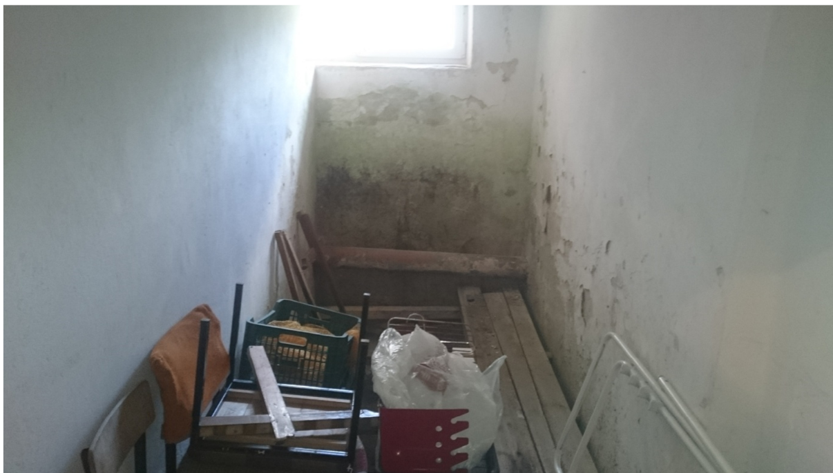
Fot. 10 Całkowicie mokra , zagniała i zagrzybiona ściana piwnic
