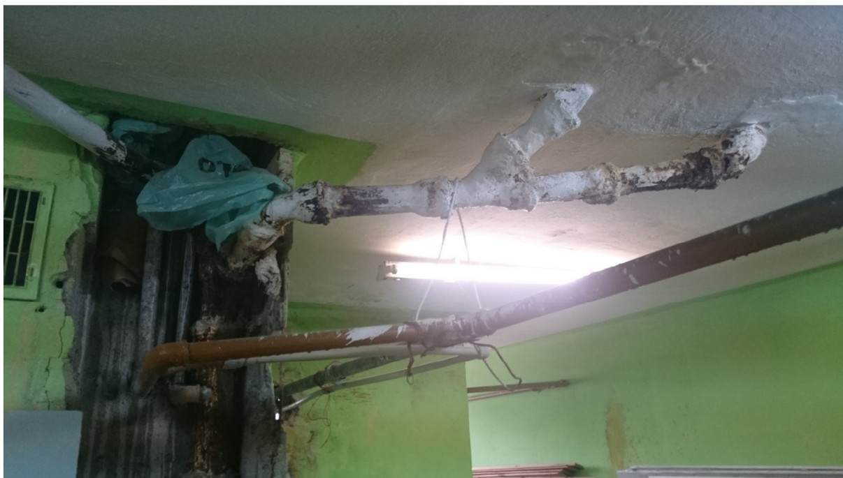
Fot. 12 Skorodowane elementy stalowe w piwnicach
