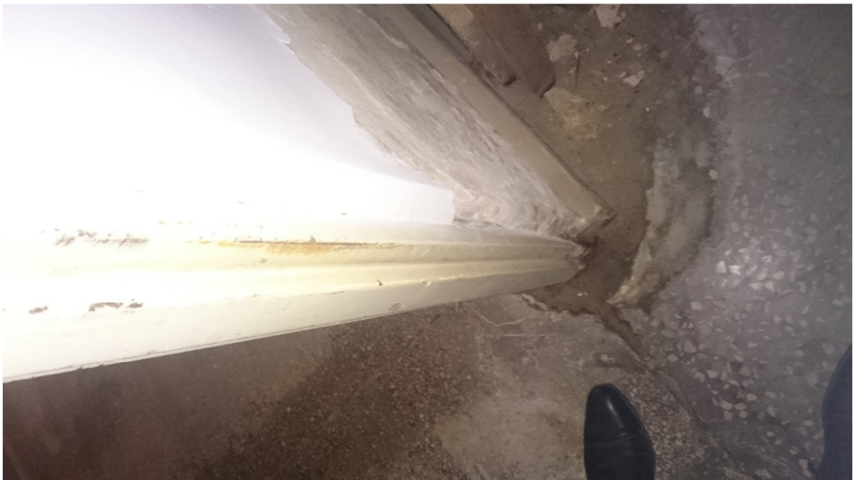
Fot. 6 Całkowicie mokra , zagnięta i zagrzybiona ściana działowa piwnic wraz z nieszczalną posadzką
