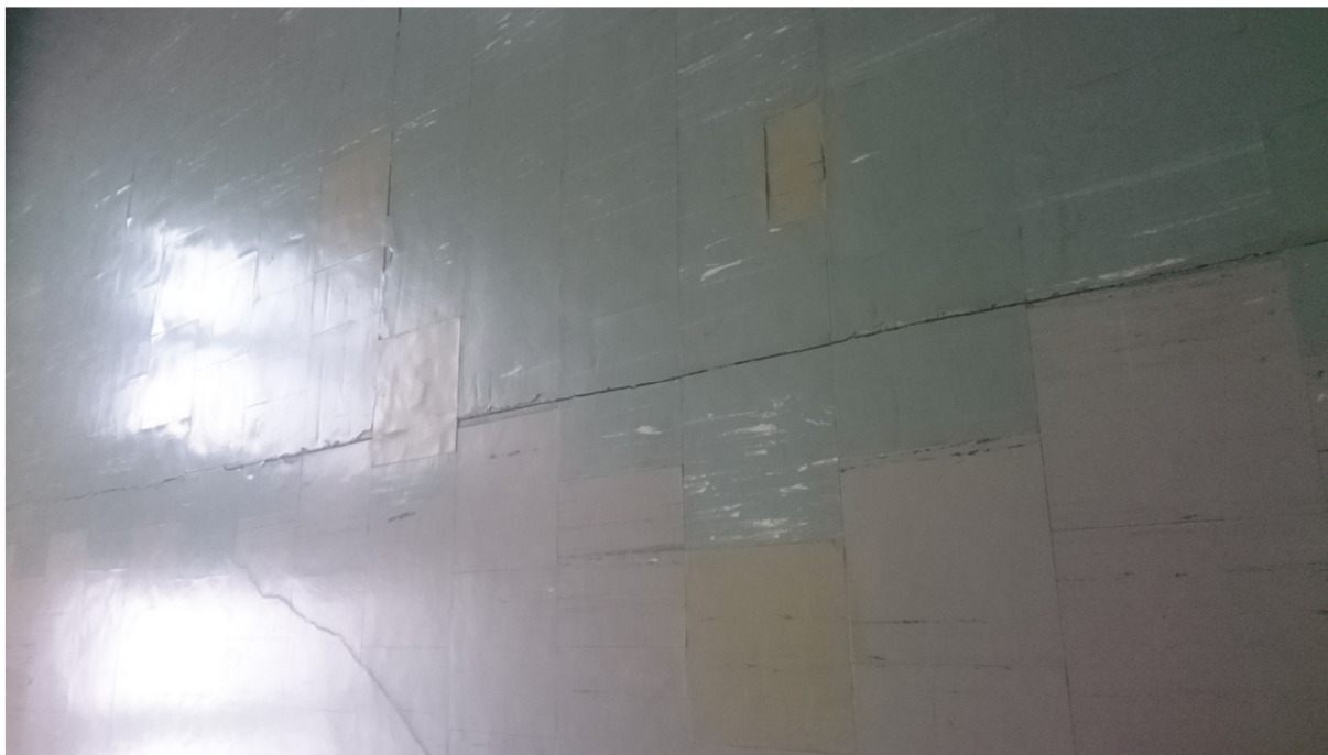
Fot. 25 Zarysowanie posadzki na wskutek klawiszowania płyt stropowych
