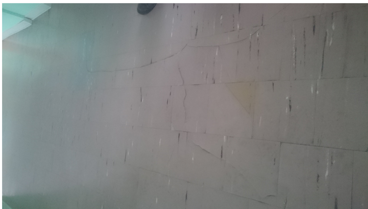
Fot. 24 Zarysowanie posadzki na wskutek klawiszowania płyt stropowych
