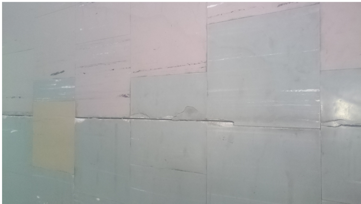
Fot. 23 Zarysowanie posadzki na wskutek klawiszowania płyt stropowych
