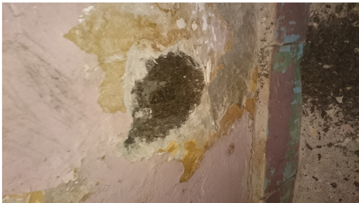
Fot. 3 Całkowicie mokra i zagniła izolacja ścian piwnic z płyt wiórowo - cementowych
