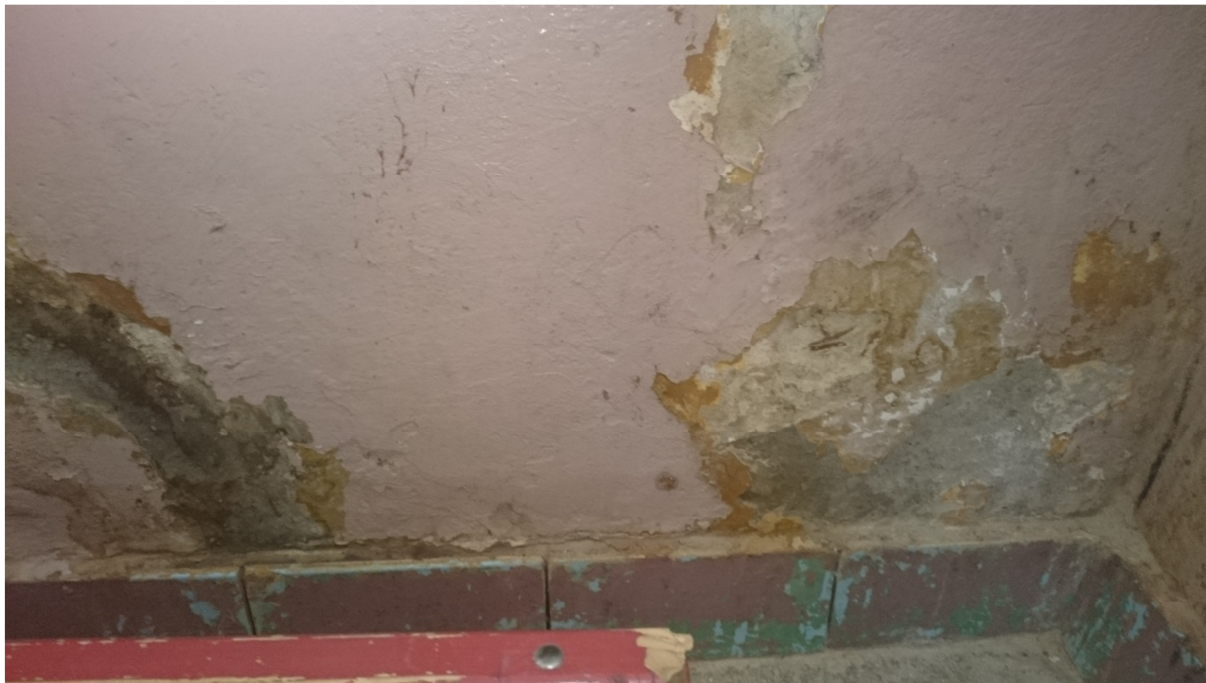
Fot. 12 Skorodowane elementy stalowe w piwnicach
