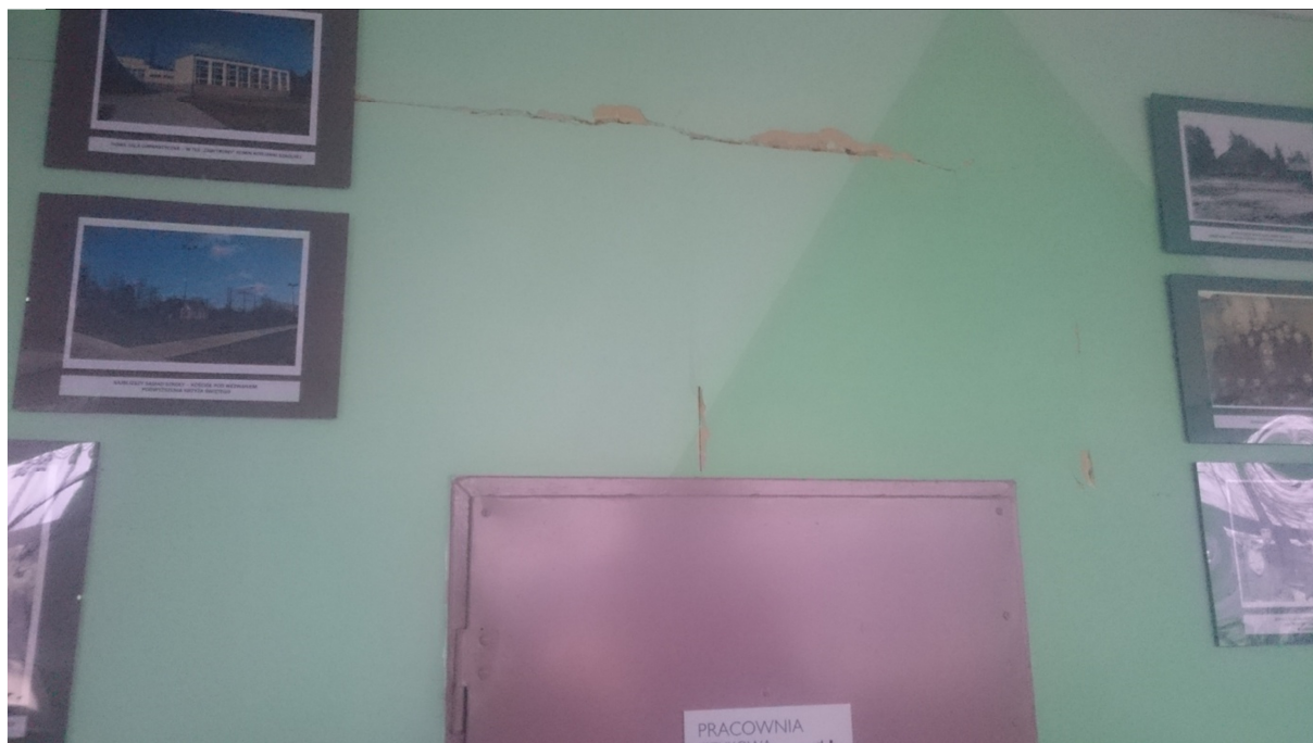
Fot. 29 Zarysowanie ścian
