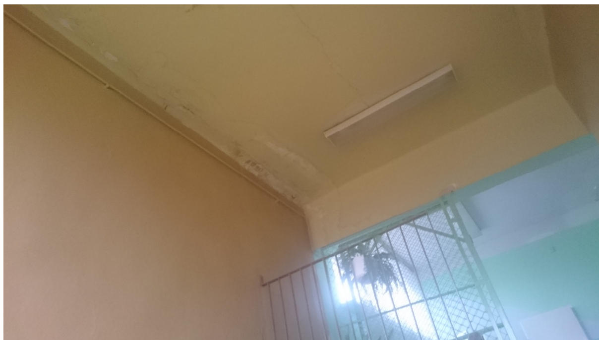
Fot. 18 Zawilgocenie ścian i sufitów wskutek nieszczelnego dachu
