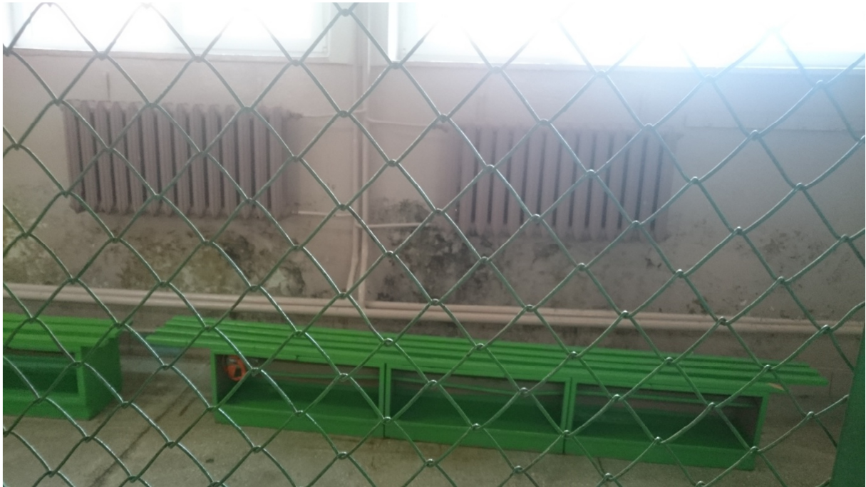
Fot. 6 Całkowicie mokra , zagnięta i zagrzybiona ściana działowa piwnic wraz z nieszczalną posadzką
