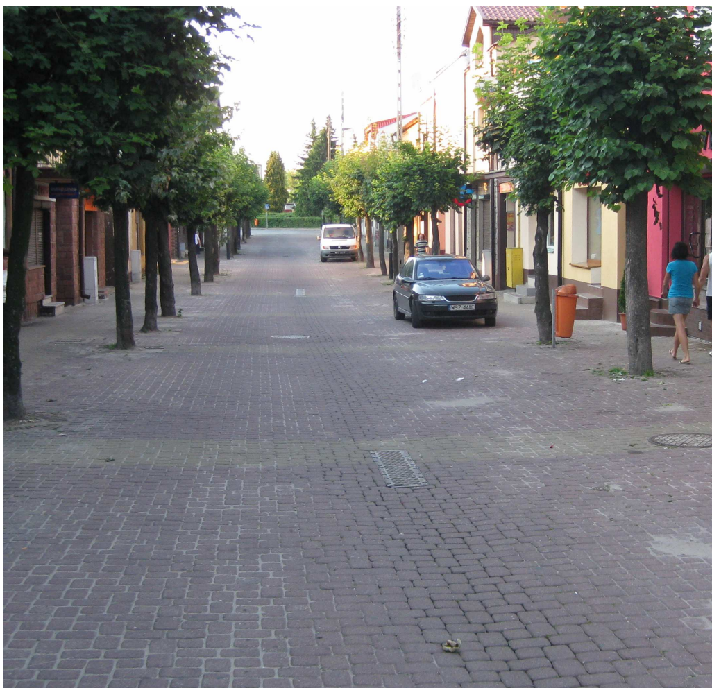
Zdjęcie 1. Ulica Radomska -istniejące odwodnienie liniowe, kostka betonowa kolor czerwony i żółty.
