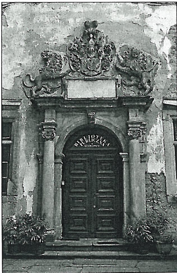
Fot.49 Szydłowiec, Zamek – elewacja wewnętrzna zachodnia. XVII w. portal z herbem. Stan zachowania przed konserwacją. Widoczna destrukcja tynków. 04. 2010r. wyk. K. Mikołajek
