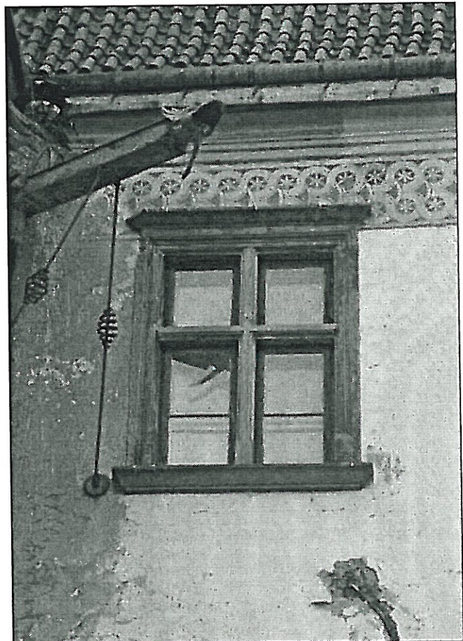
Fot.39 Szydłowiec, Zamek – elewacja wewnętrzna południowa. Oryginalna kamieniarka okna II piętra. Stan zachowania przed konserwacją. Widoczne ubytki kamienia. 04. 2010r. wyk. K. Mikołajek
