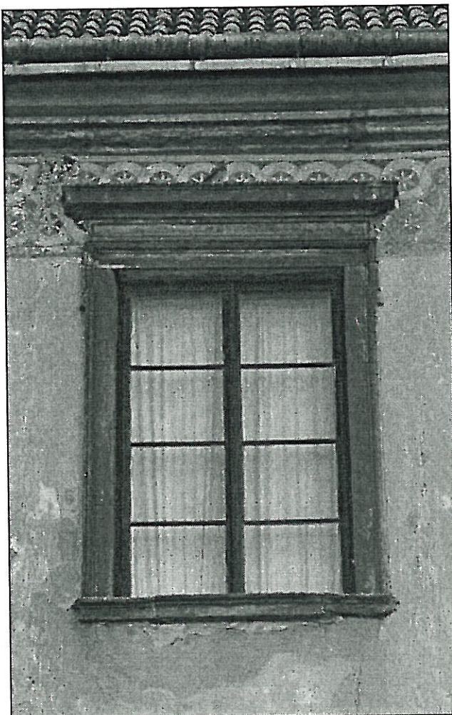
Fot.47 Szydłowiec, Zamek – elewacja wewnętrzna zachodnia. Fragment II piętra z sgraffitem i malowanym na czerwono gzymsem. Stan zachowania przed konserwacją. Widoczna destrukcja sgraffita. 04. 2010r. wyk. K. Mikołajek
