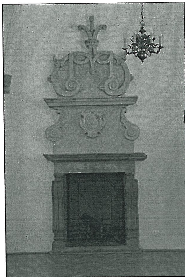
Fot. 83 Szydłowiec, Zamek – zabytkowe elementy wnętrza. Kominiek z orłem radziwiłłowskim w pomieszczeniu nr 2.19 Stan zachowania przed konserwacją. 04. 2010r. wyk. K. Mikołajek
