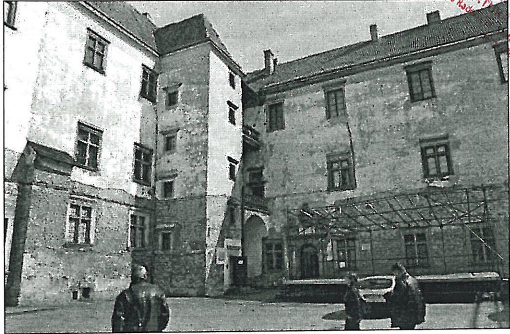
Fot.41 Szydłowiec, Zamek – elewacja wewnętrzna południowa i zachodnia. Widok ogólny Stan zachowania przed konserwacją. Widoczna destrukcja tynków. 04. 2010r. wyk. K. Mikołajek
