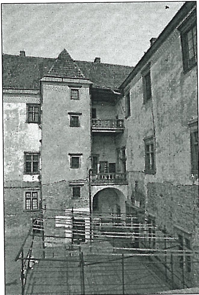
Fot.41 Szydłowiec, Zamek – elewacja wewnętrzna południowa i zachodnia. Widok ogólny Stan zachowania przed konserwacją. Widoczna destrukcja tynków. 04. 2010r. wyk. K. Mikołajek
