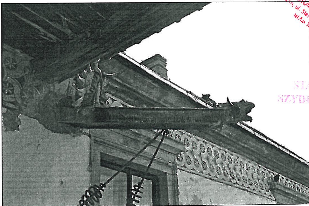
Fot.47 Szydłowiec, Zamek – elewacja wewnętrzna zachodnia. Fragment II piętra z sgraffitem i malowanym na czerwono gzymsem. Stan zachowania przed konserwacją. Widoczna destrukcja sgraffita. 04. 2010r. wyk. K. Mikołajek
