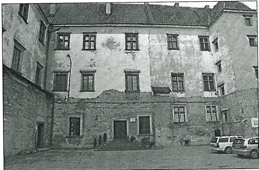
Fot.38 Szydłowiec, Zamek – elewacja wewnętrzna płudniowa. Widok ogólny Stan zachowania przed konserwacją. Widoczna destrukcja tynków. 04. 2010r. wyk. K. Mikołajek
