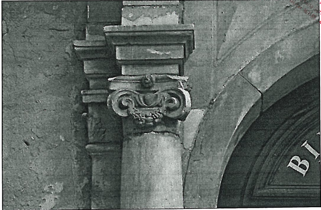
Fot.51 Szydłowiec, Zamek – elewacja wewnętrzna zachodnia. Fragment dekoracji portalu. Stan zachowania przed konserwacją. Widoczna destrukcja formy rzeźbiarskiej i spoinowania. 04. 2010r. wyk. K. Mikołajek
