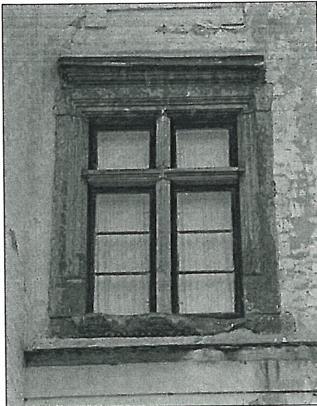
Fot.12 Szydłowiec, Zamek – elewacja południowa. Fragment ściany skrzydła wschodniego, oryginalna kamieniarka okienna. Widoczna destrukcja wyprawy tynkowej. Stan zachowania przed konserwacją 04. 2010r. wyk. K. Mikołajek
