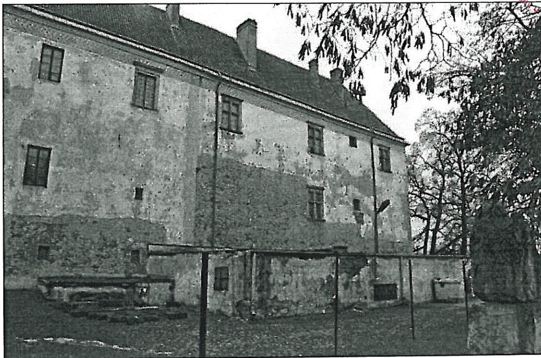
Fot.26 Szydłowiec, Zamek – elewacja północna. Fragment skrzydła północnego wraz z przybudówką w części parteru. Stan zachowania przed konserwacją. Widoczna destrukcja tynków. 04. 2010r. wyk. K. Mikołajek
