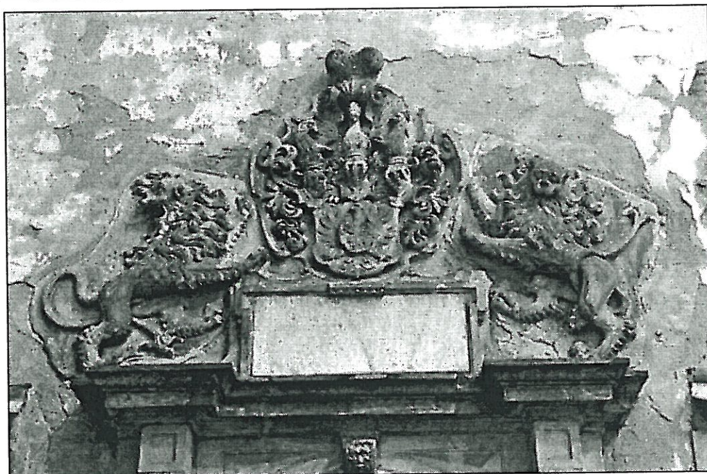
Fot.50 Szydłowiec, Zamek – elewacja wewnętrzna zachodnia. Fragment zwieńczenia portalu Stan zachowania przed konserwacją. 04. 2010r. wyk. K. Mikołajek
