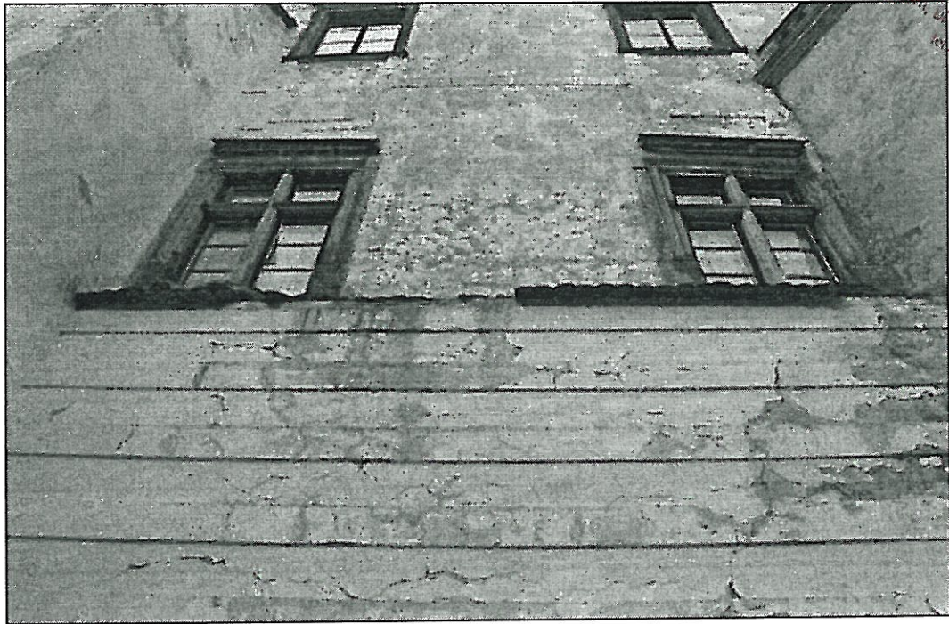
Fot.12 Szydłowiec, Zamek – elewacja południowa. Fragment ściany skrzydła wschodniego, oryginalna kamieniarka okienna. Widoczna destrukcja wyprawy tynkowej. Stan zachowania przed konserwacją 04. 2010r. wyk. K. Mikołajek
