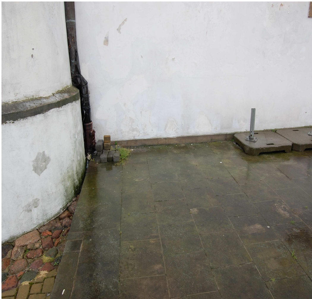
Fot. 5. Obserwowana korozja elewacji spowodowana niewłaściwą gospodarką wodami opadowymi. Elewacja północna.
