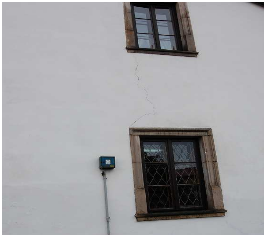
Fot. 3. Widoczne pęknięcia i zarysowania na elewacji północnej budynku.
