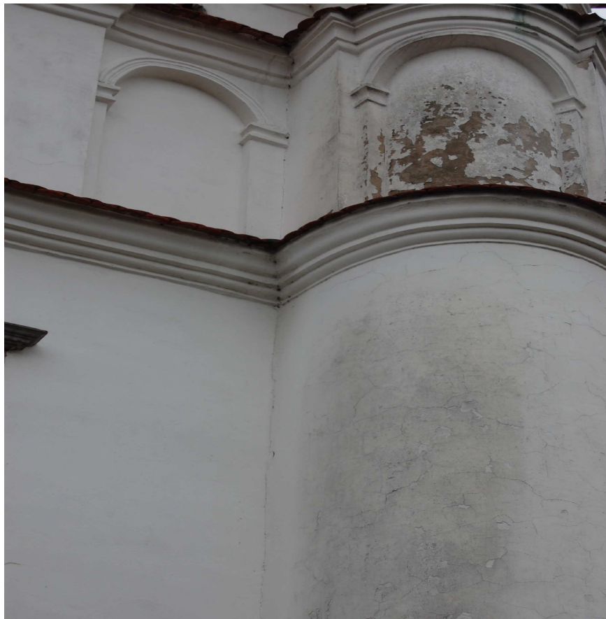
Fot. 6. Obserwowana korozja elewacji spowodowana niewłaściwą gospodarką wodami opadowymi .Elewacja zachodnia.
