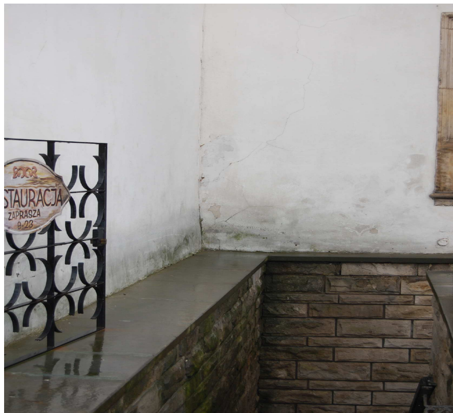
Fot. 2. Zawilgocenia ścian parteru obserwowane na północnej elewacji wieży oraz wschodniej elewacji budynku głównego Ratusza.
