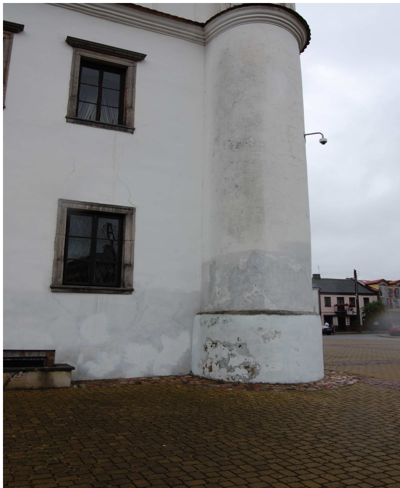
Fot. 1. Widoczne zawilgocenia ścian zewnętrznych na elewacji wschodniej budynku Ratusza.
