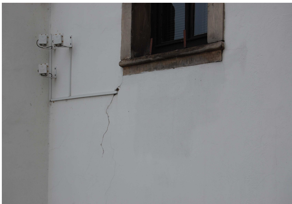
Fot. 4. Widoczne pęknięcie na elewacji zachodniej budynku w poziomie pierwszego piętra.
